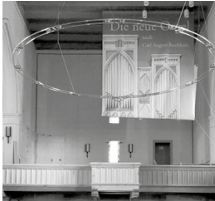
der Fußboden wurde ausgebessert, teils ...
